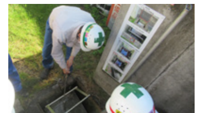
汚水流出を想定した、流出防止ゲートの取扱い訓練(神鋼アクテック(株))
