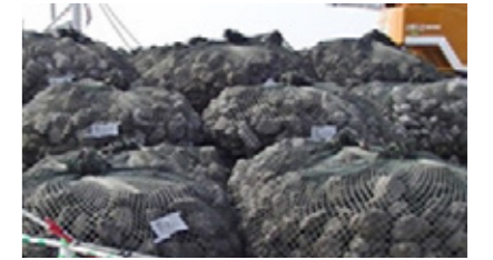
潜堤構築材 (中詰材：鉄鋼スラグ水和固化体)
