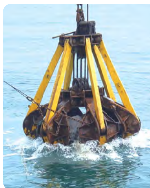
▲スラグ石材潜堤施工状況 (兵庫県淡路島)
