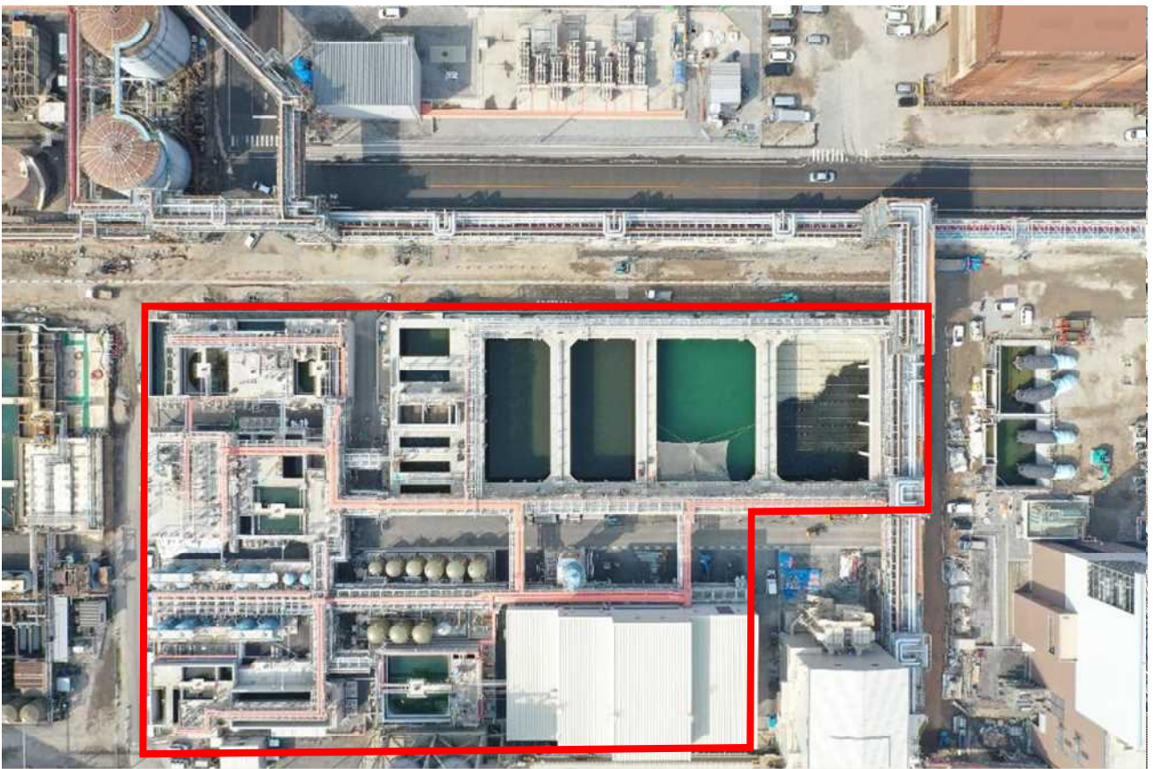
写真 5.2-1 総合排水処理設備（新設）の設置状況
