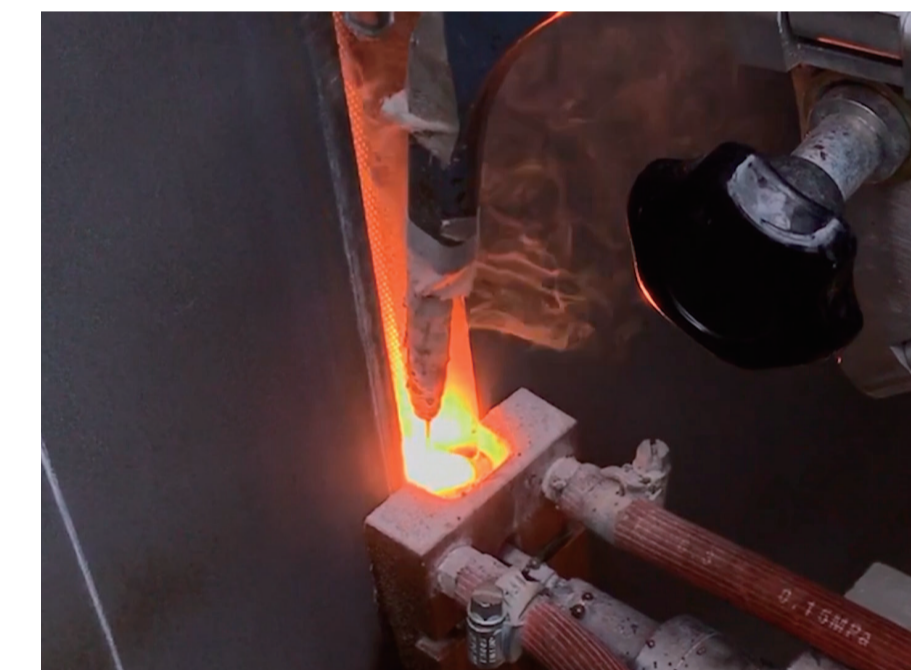
立向自動溶接
