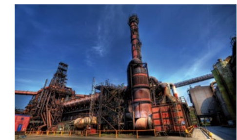
ArcelorMittal社ドイツ・ハンブルク工場 既設の直接還元鉄プラント
