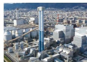
神戸発電所3・4号機
