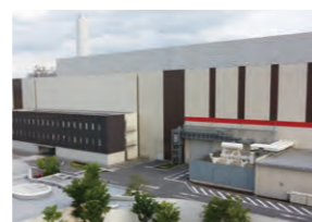
真岡発電所1・2号機
