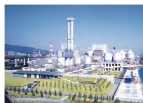
神戸発電所1・2号機
