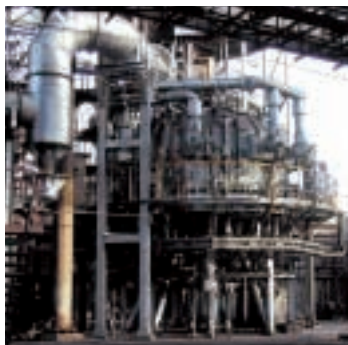
当社の加古川製鉄所内に建設されたパイロットプラント
