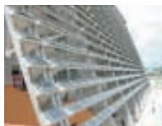
市庁舎南面の水平遮光ルーバーに取り付けられた太陽電池モジュール
