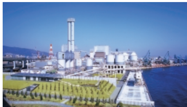
神鋼神戸発電所
