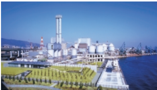
神鋼神戸発電所
