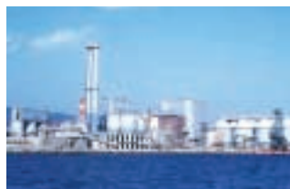
神鋼神戸発電所
