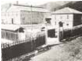
昭和29年当時の本社ビル
