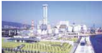
神鋼神戸発電所
