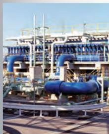
开架式LNG气化器“ORV”
