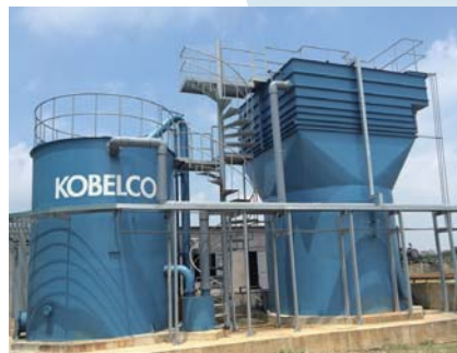
交付给Thalbeco公司的混凝沉淀和自动虹吸滤池
