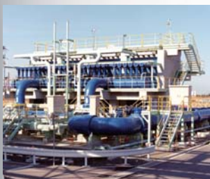
开架式LNG气化器“ORV”
