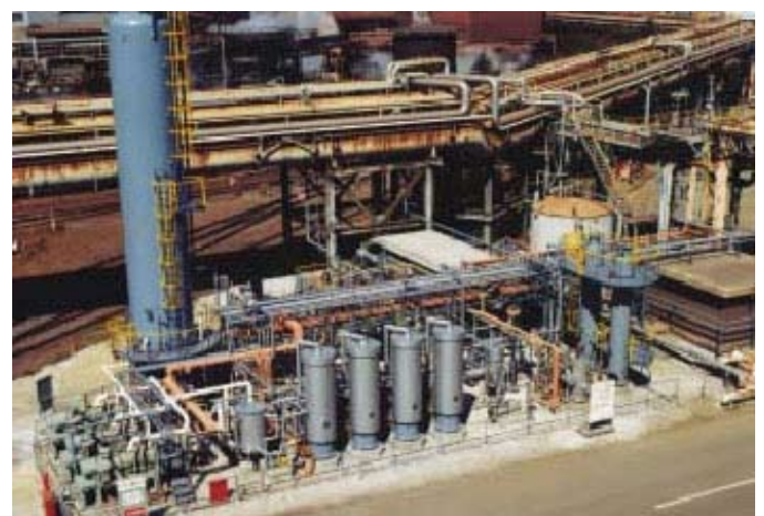
▲加古川製鉄所 CO-PSA 商業プラント (製品CO流量:150Nm 3 /hr)
