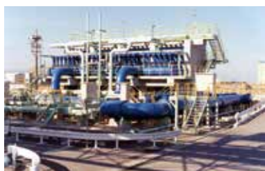
Open-rack LNG vaporizer
