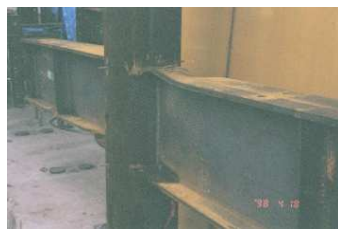
破壊状況(梁の局部座屈)*3
