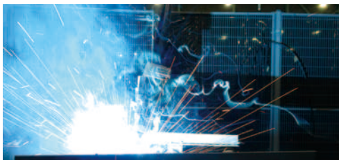
通常の炭酸ガスアーク溶接
