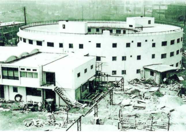
建設中の神鋼病院
