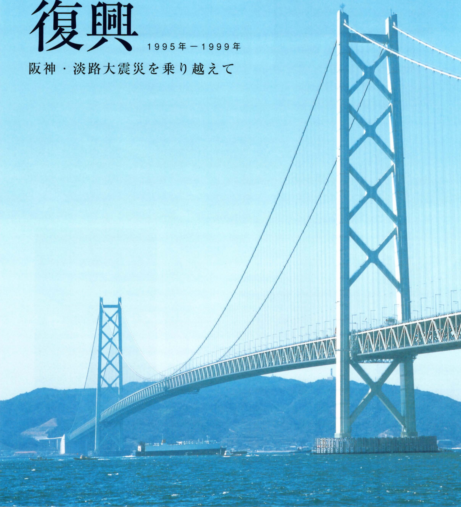
明石海峡大橋
