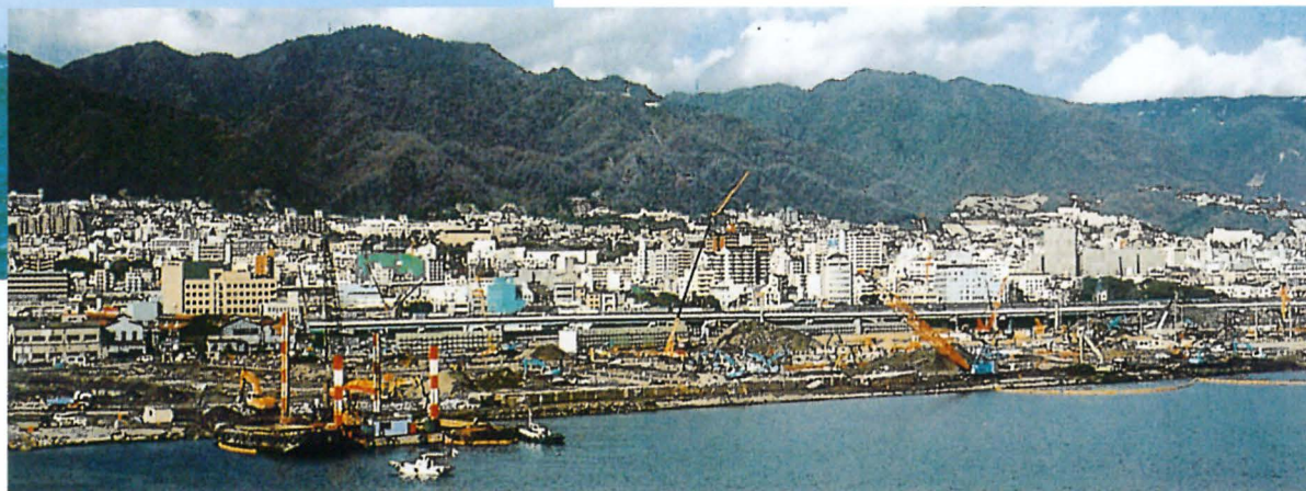
建設が進む神戸市東部新都心
