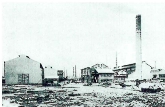
協浜の埋立工事
