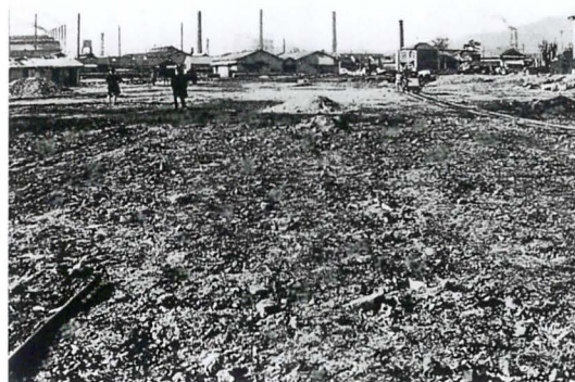
東海岸埋立工事（1933年頃）
