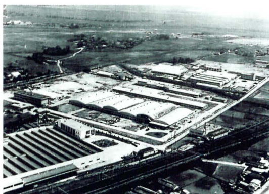
茨木工場全景（1961年頃）
