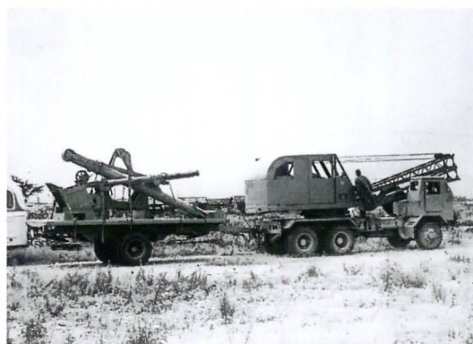
トラッククレーン
