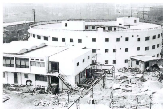
建設中の神鋼病院
