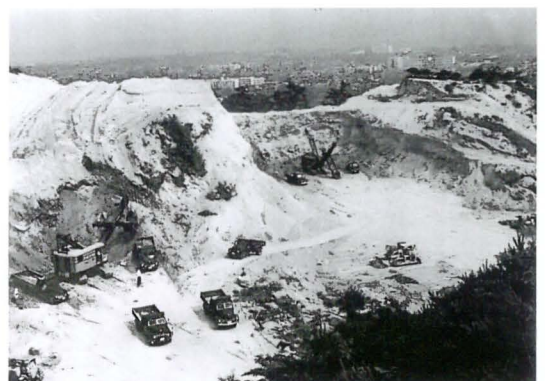
灘浜海岸埋立のために行われた、丸山の削土作業(1957年頃)
