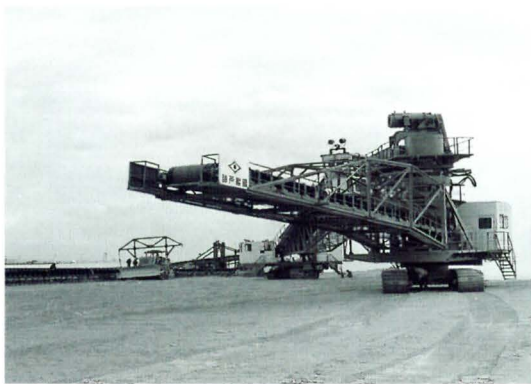
ポートアイランド埋立用移動式コンベア
