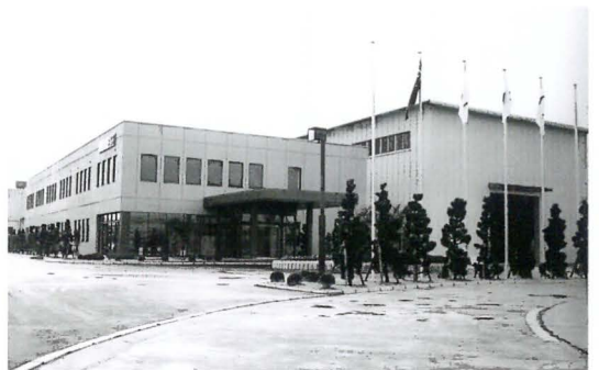
建設機械研修センター（1983年）
