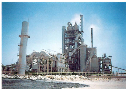
エジプトセメントプラント
