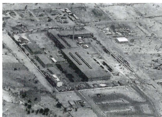
ナイジェリア棒鋼線材圧延工場
