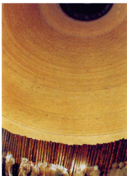
再火入れ前の加古川製鉄所第1号高炉の内部
