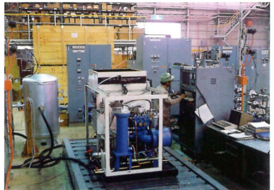
汎用圧縮機工場
