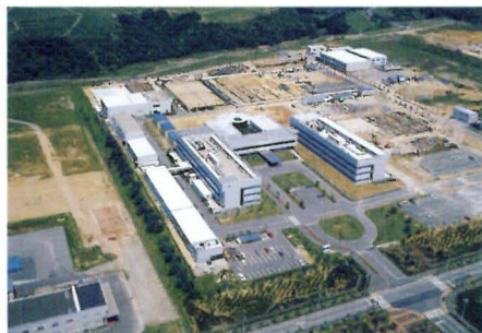
神戸市西神地区に建設された神戸総合技術研究所
