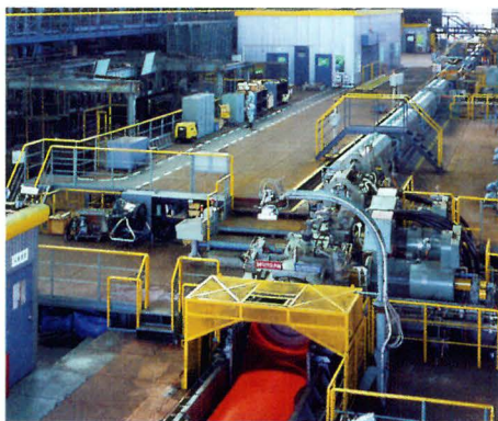
リフレッシュした神戸製鉄所第7線材工場
