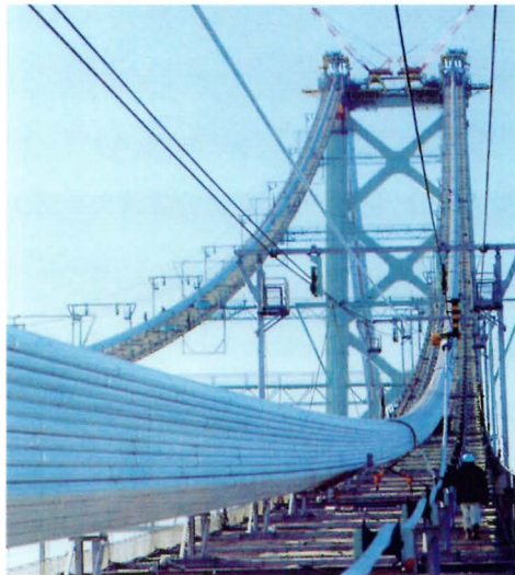
ケーブル架設中の明石海峡大橋
