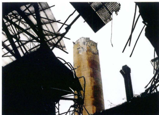
倒壊した神戸製鉄所第7線材工場の煙突
