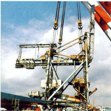
加古川製鉄所 アンローダの復旧作業
