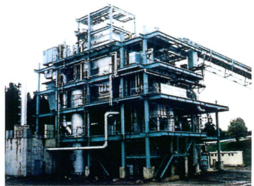
流動床式熱分解溶融炉
