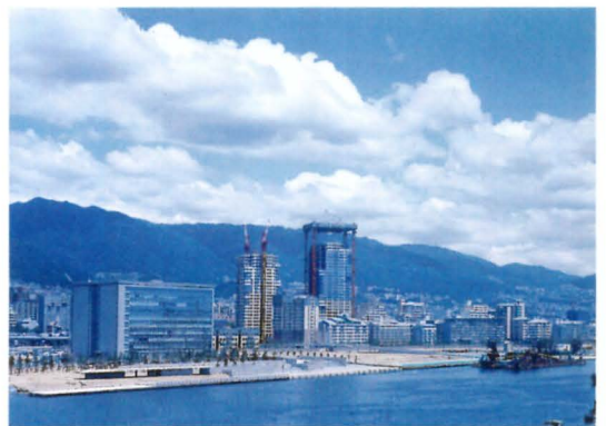
建設の進む神戸市東部新都心
