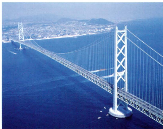
明石海峡大橋
