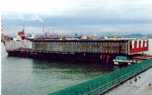
那覇港道路（空港線）沈埋函の出荷
