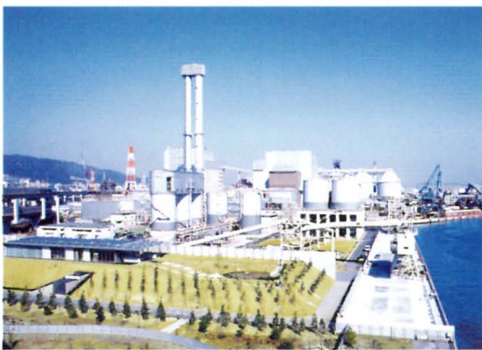
神鋼神戸発電所
