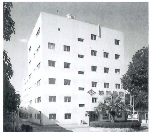
機械研究所（1977年完成）
