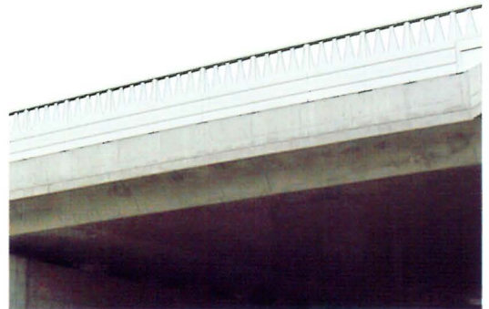
山形防音壁を有する高架道路
