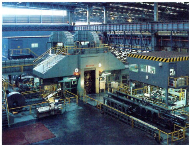
加古川製鉄所 レバースミル 薄板への薄肉化、高品質化などのニーズに応えた。圧延速度は世界最高速（当時）。加古川製鉄所の冷延は従来のタンデムミルと合わせ2基体制となった
