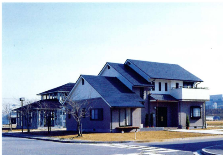
神戸総合技術研究所のスチールハウス実験棟
