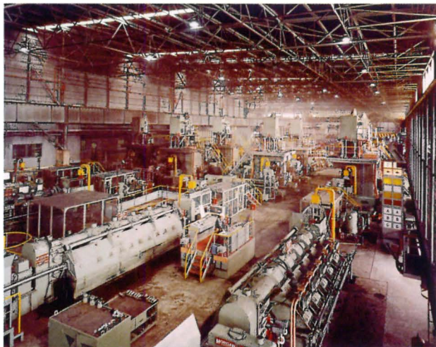
加古川製鉄所 第2期工事で稼働した第8線材工場
