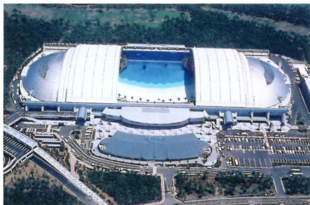
宮崎県フェニックス・シーガイア・リゾートの「オーシャンドーム」に採用されたチタン製屋根
