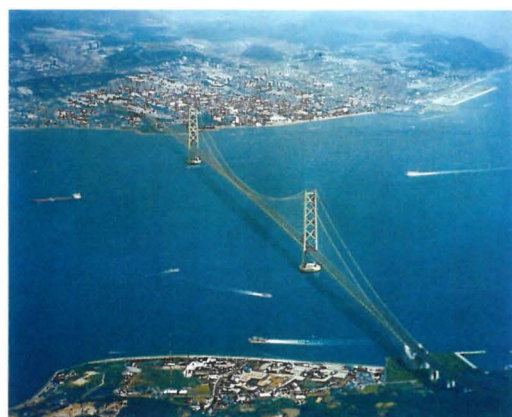
180kgf/mm 2 の高張力鋼線が支える明石海峡大橋 180kgf/mm 2 の高強度亜鉛めっき鋼線の開発が、明石海峡大橋などの長大吊橋の構造をシンプルにし、景観性を高めた
