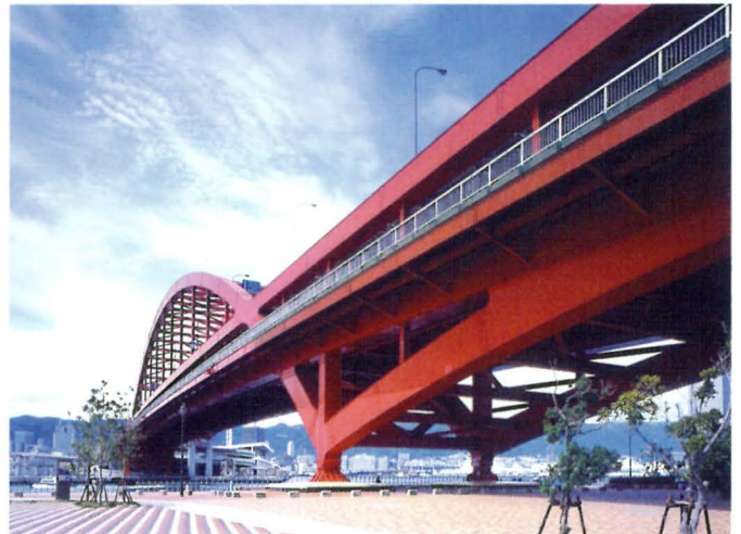
厚板を使用した橋梁（神戸大橋）
