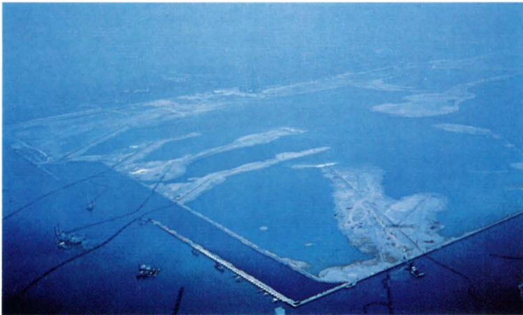
加古川製鉄所の建設風景
