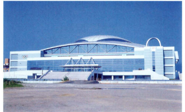
カラー鋼板が採用された長野冬季オリンピック会場 亜鉛めっきを施し、フッ素樹脂塗料を塗装・焼付けしている
