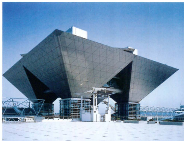
東京ビッグサイト チタン建材としては世界最大物件（総量140ト）となった
