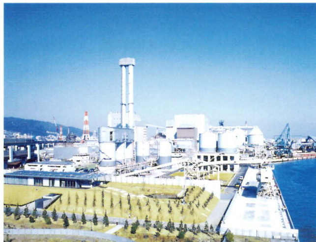
神鋼神戸発電所
