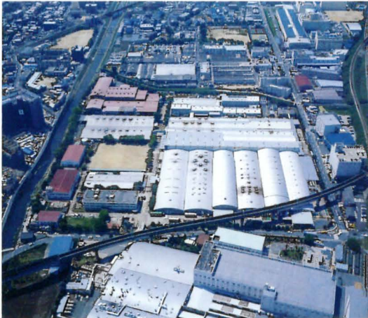
溶接材料専用の茨木工場
