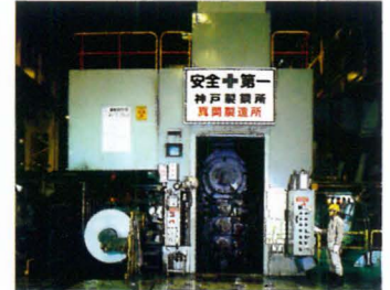
真岡製造所 冷間仕上圧延機
