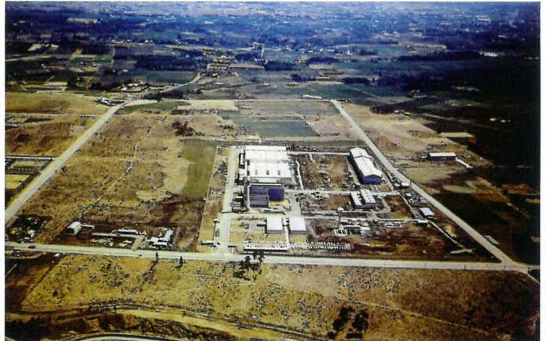
真岡工場 第1期工事が完了 (1969年)
