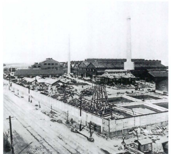
建設中の長府工場（1939年ごろ）
