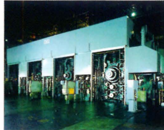
真岡製造所 熱間仕上圧延機
