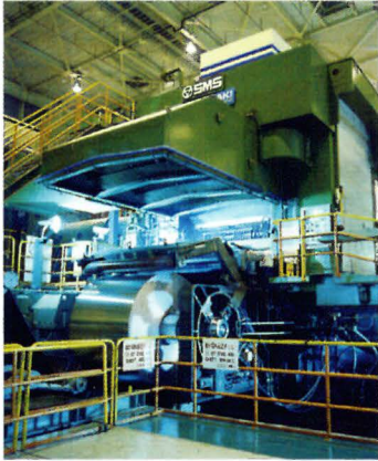
2タンデム冷間圧延機
