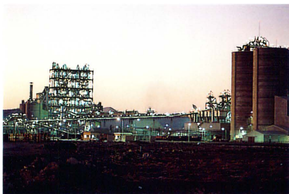
ヨルダンのJordan Cement Factories社向けプロジェクトは、当社が完成したプラントの増強工事で、原料破碎・搬送・貯蔵とセメントミルを増設した
