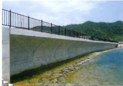
フレア護岸 広島県・倉橋町（2005年完成）
