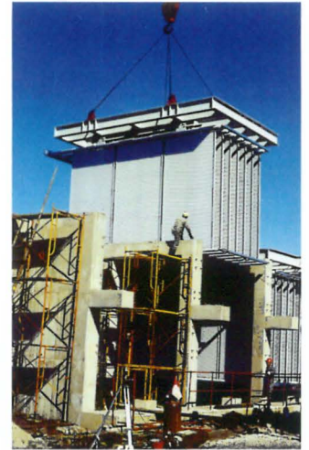
ORVのブロック据付
