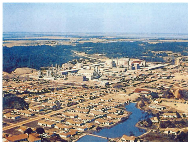
東パキスタン（現・バングラデシュ）向け尿素肥料プラント わが国プラント輸出の原点となった（1962年）
