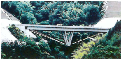
ケーブルトラス橋 竹花橋（1997年完成）
