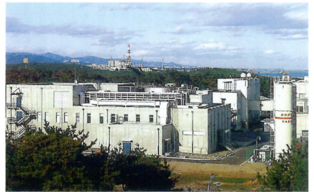
クリプトン回収技術開発施設
