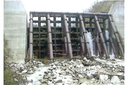
鋼製えん堤 岐阜県・菅沼谷砂防えん堤（2002年完成）
