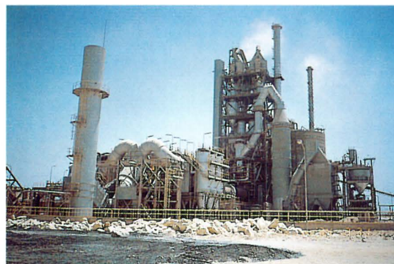
エジプトのBeni Suef Cement社向けプラント 原料石灰石中の塩分濃度が高く、通常のプレヒーターでは詰まりやすく運転に支障を来すため、世界で初めて100%塩素バイパス設備を導入した
