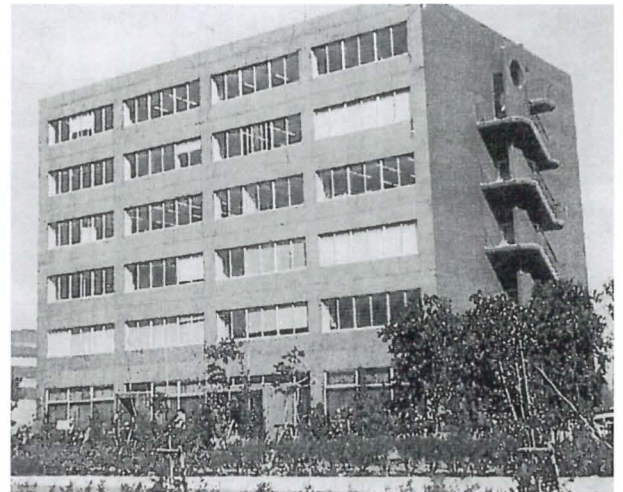
神鋼興産(株)初の自社賃貸ビルとなった「加古川神鋼ビル」
