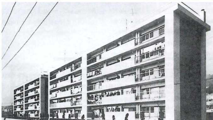
山御影マンションのA、B棟
