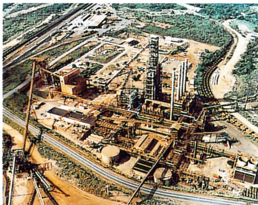
ベネズエラに直接還元製鉄プラントを建設
