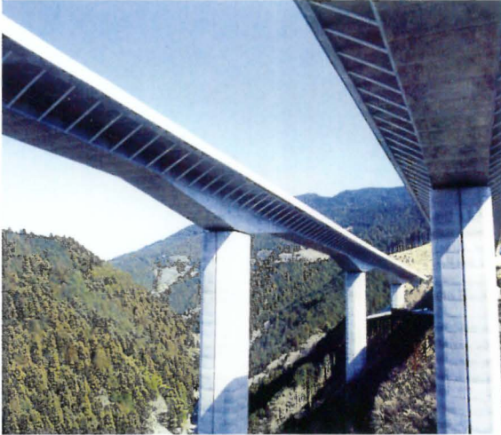
PC鋼線が使用された道路
