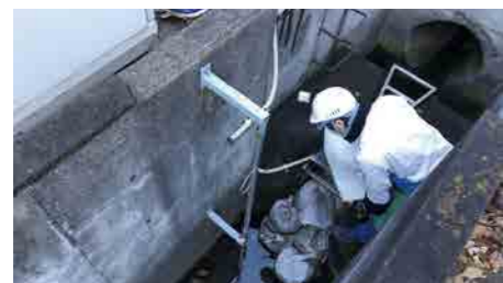
油流出を想定し土嚢や油吸着マットを設置する訓練(神戸ノース(株))
