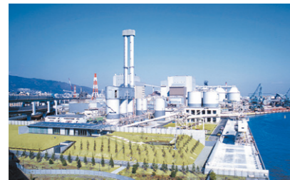
神戸発電所1・2号機
