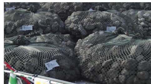
潜堤構築材(中詰材:鉄鋼スラグ水と固化体)
