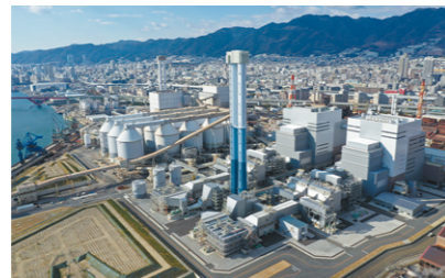
神戸発電所3・4号機
