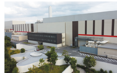
真岡発電所1・2号機
