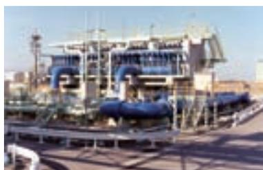
Open-rack LNG vaporizer
