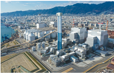
神戸発電所3・4号機
