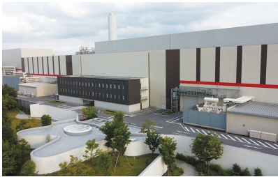
真岡発電所1・2号機
