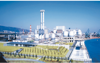
神戸発電所1・2号機
