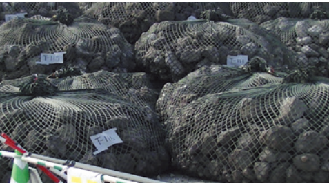
潜堤構築材(中詰材:鉄鋼スラグ水和固化体)
