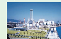
神戸発電所1・2号機
