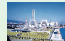
神戸発電所1・2号機
