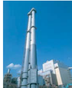
神鋼神戸発電所
