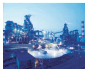
加古川製鉄所 高炉夜景
