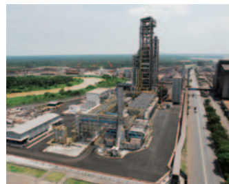
還元鉄プラント(インドネシア)
