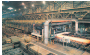
現状の厚板加速冷却設備
