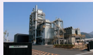
福井グリーンパワー大野発電所 (木質バイオマス発電設備)
