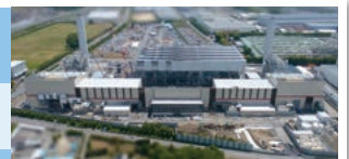
建設中の真岡発電所
