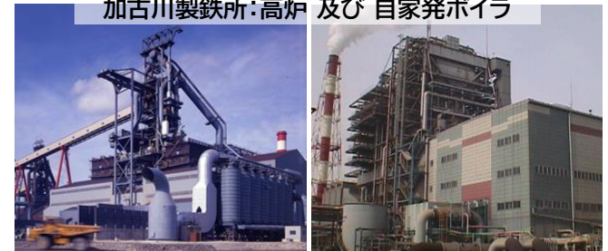
加古川製鉄所:高炉 及び 自家発ボイラ
