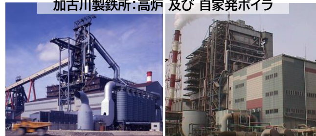
加古川製鉄所:高炉 及び 自家発ボイラ
