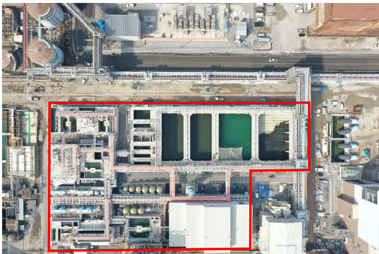
写真 4.2-1 総合排水処理設備（新設）の設置状況
