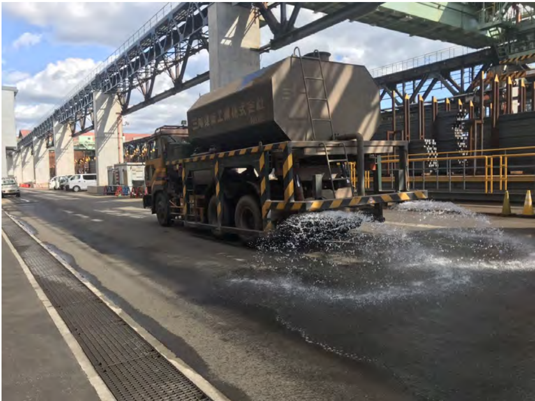
写真 4.1-1 令和元年度における車両洗浄及び道路散水の実施状況
