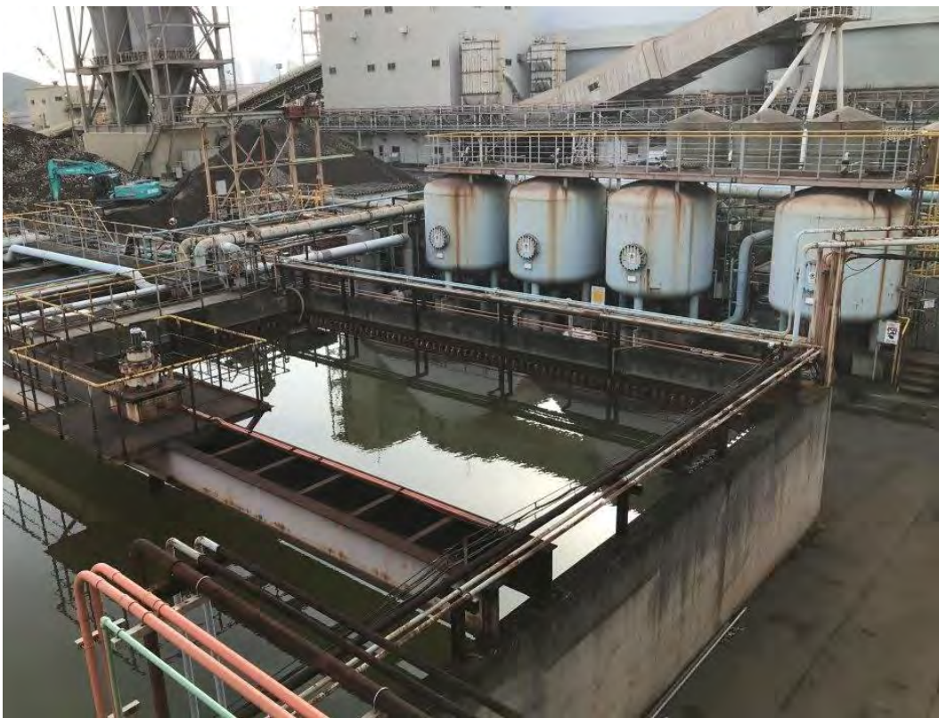
写真 4.4-1 工事排水処理設備の設置状況
